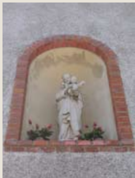
103. Nicchia in facciata
