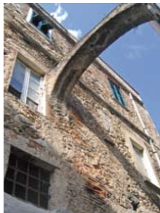
11. Un rustico edificio di Barescione
