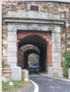
92. Portale di forte Centrale
