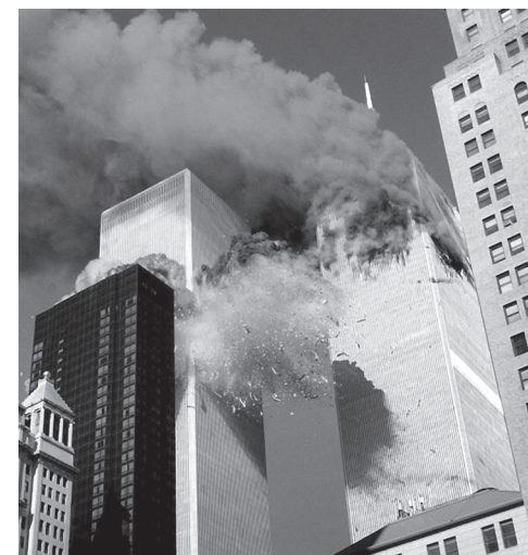
Figura 2.8. New York, 11 settembre 2001. Le due Torri Gemelle del World Trade Center in fiamme dopo che il secondo aereo ha appena colpito la torre sud.
