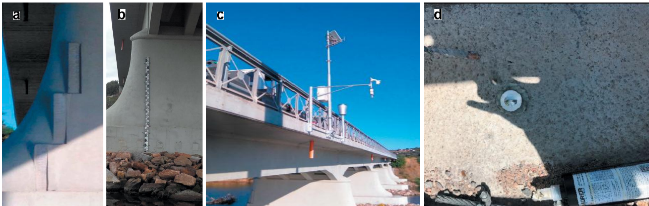
a) 1ª Asta idrometrica; b) 2ª Asta idrometrica; c) Stazione telemisura; d) Caposaldo (secondario nei pressi del sensore idrometrico) chiodo.
