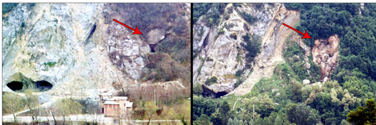
Le frecce indicano l'ingresso della Grotta del Farneto prima e dopo il rovinoso crollo del portale. A sinistra il fronte della collina nel 1972, a destra nel 1991 a disastro compiuto. (Foto dell'A.)
