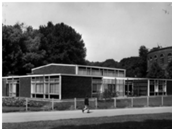
W.D. Lacey, Scuola elementare realizzata con il sistema CLASP e donata al Comune di Milano dal Ministero dell'Istruzione Inglese, esposta a Parco Sempione in occasione della XII Triennale, 1960. Milano, Archivio Storico della Triennale di Milano, XII Triennale.
