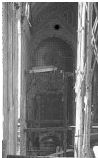
Fig. 15: Restauro della zona absidale della chiesa dei Servi di Padova, particolare della cappella del Crocifisso, 1926-1929 (SABPVePd, Archivio fotografico, inv. 27282).
