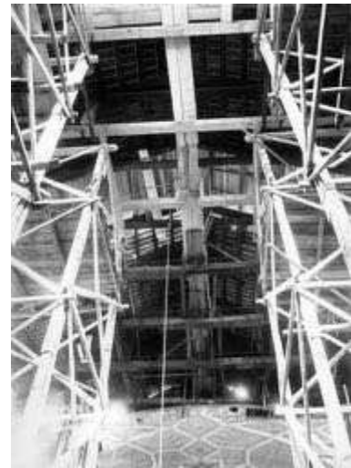
Fig. 14: Restauro della parete est della chiesa dei Servi di Padova (a sinistra) e della copertura e disfacimento del solaio ottocentesco (a destra), 1926-1929 (SABPVePd, Archivio fotografico, invv. 27283-27284).
