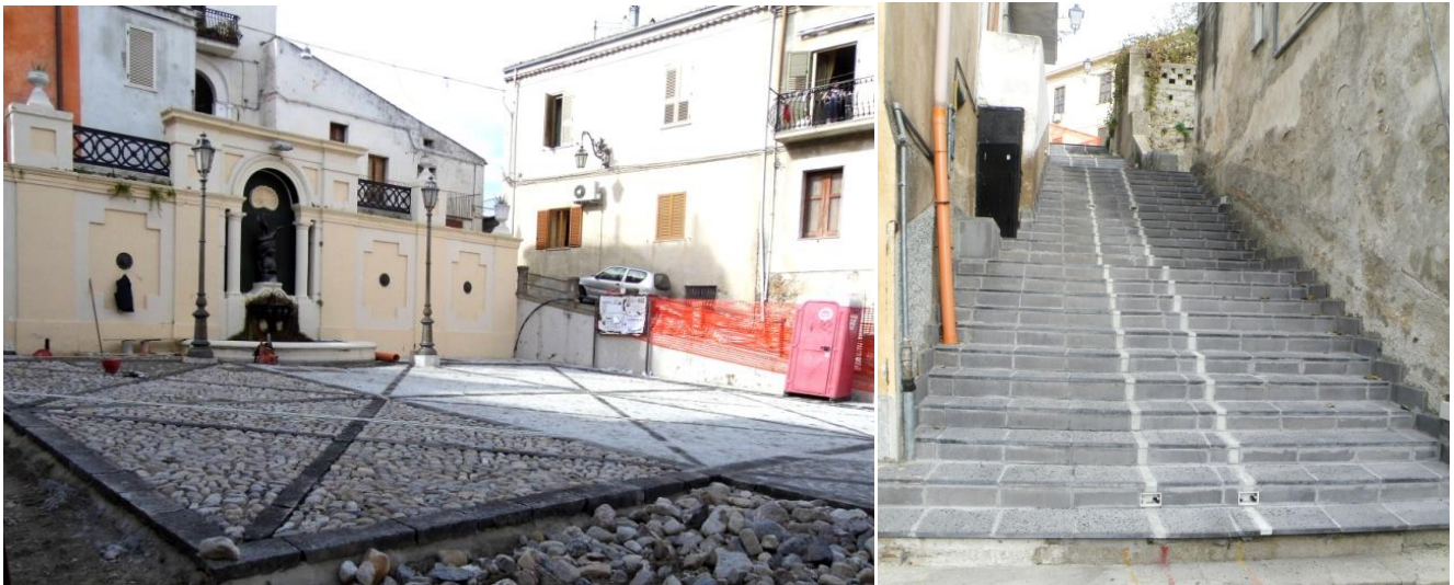
La "Piazza Sirena o Grottaferrata" e la scalinata di accesso all'ex Castello, nel 2010, durante i lavori di sistemazione e ripavimentazione previsti dal progetto di arredo urbano, deliberato dalla Giunta Municipale Filareto (Foto M. Massoni).
