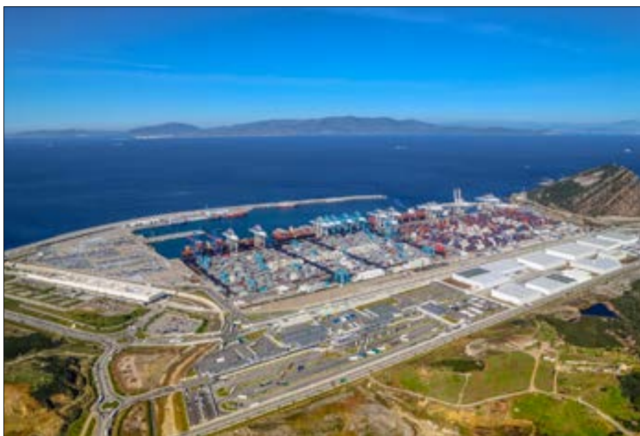
IL PORTO DI TANGERI (MAROCCO): DUE TERMINAL FAVORISCONO UNA CRESCITA STRAORDINARIA
