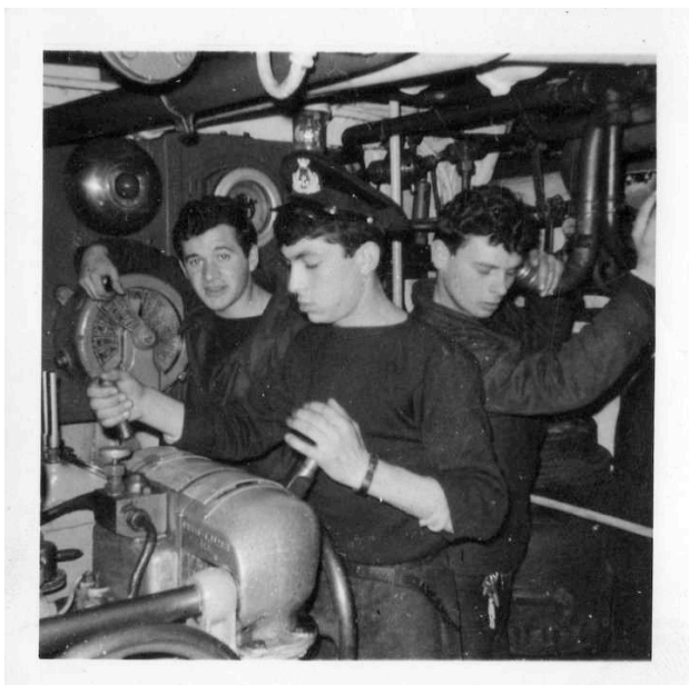
Fig. 152- Personale al posto di manovra sul pulpito di un motore MS407 sulle corvette classe APE negli anni '60. Spesso la rapidità e la frequenza delle manovre di arresto, inversione ed avviamento davano luogo a vere e proprie gare di abilità tra il personale dei due motori affiancati Le condizioni di vita a bordo non erano certamente di grande conforto, e meno in macchina
