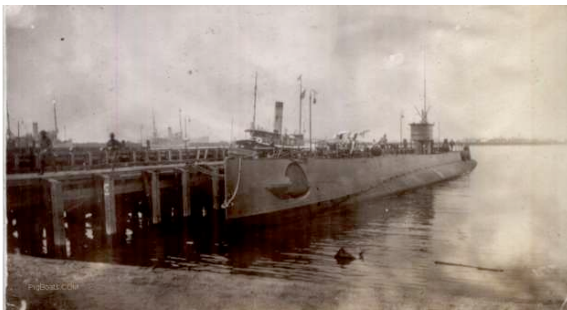
Fig. 227 - Lo USS T-3 – Primo e infelice tentativo della US Navy di dotarsi di un fleet submarine - Dopo essere stato ritirato dal servizio, nel 1922 fu modificato imbarcando nuovi motori, di fornitura dello stesso BuEng quali cloni dei motori MAN e fu a lungo impiegato per il solo scopo di valutare le prestazioni dei motori diesel MAN (NavSource: Submarine Photo Archive)
