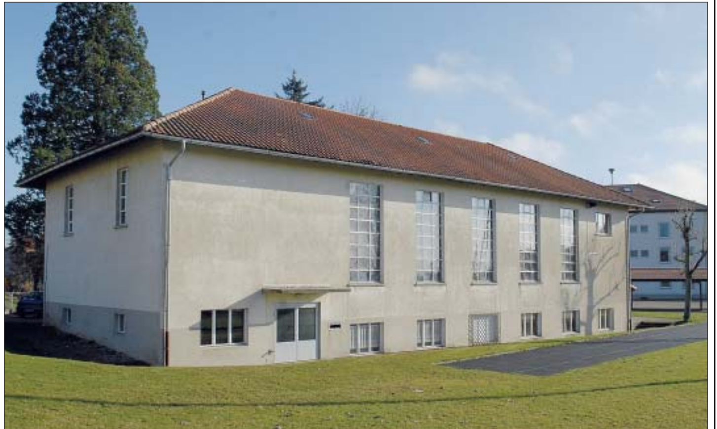
Une nouvelle halle de sport sera construite. La commission en charge du dossier va tenter de trouver un avenir à l'ancienne halle via une formule privée.
