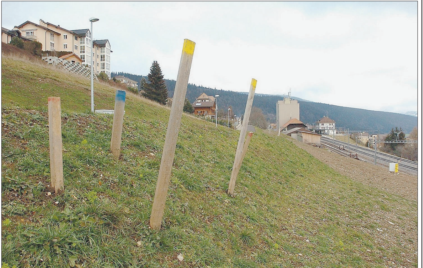
La commune entend profiter du chantier en cours de la route du Bugnon pour y installer une conduite d'eaux claires.
