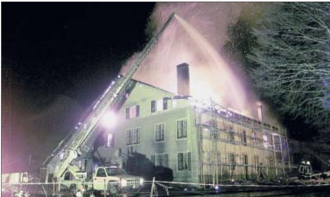
En novembre 2000, quelques heures avant que la ferme de 1670 ne parte en flammes, deux ouvriers effectuaient des travaux de soudure sur la toiture.
