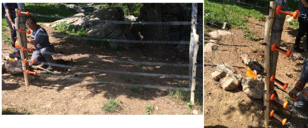
**Figura 9.1: Installazione di una recinzione fissa dotata di elettrificatore (foto A.Vareschi)**
