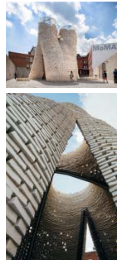
FIG. 17 Hy-Fi Bricks, David Benjamin (The Living), 2014. Progetto vincitore dello Young Architects Program, prevedeva l'ideazione di una struttura estiva temporanea realizzata con mattoni a base di bucce di mais e micelio. La forma e la disposizione dei mattoni è configurata in modo da massimizzare la ventilazione naturale e la luce dal contesto circostante. Alla fine dell'estate la struttura è stata utilizzata per il compostaggio.
