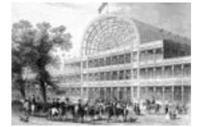
FIG. 2 Versione originale del Crystal Palace, installato nel 1851 nell'Hyde Park di Londra. Nell'illustrazione è visibile la facciata principale e il rosone ispirato alle nervature delle foglie di ninfea gigante.
