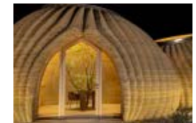
FIG. 3 TECLA (2021). Prototipo sperimentale di casa stampata in 3D progettata dall'architetto Mario Cucinella e realizzata in collaborazione con l'azienda WASP. Queste abitazioni vengono stampate in 3d, attraverso bracci robotici di grandi dimensioni e simili a delle gru, a partire dalla terra estratta sul posto e miscelata con leganti organici direttamente durante la fase di stampa.
