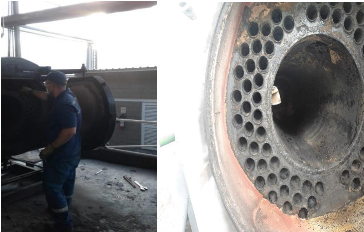
Figura 20: Tubos de la caldera y trabajos de mantenimiento.
