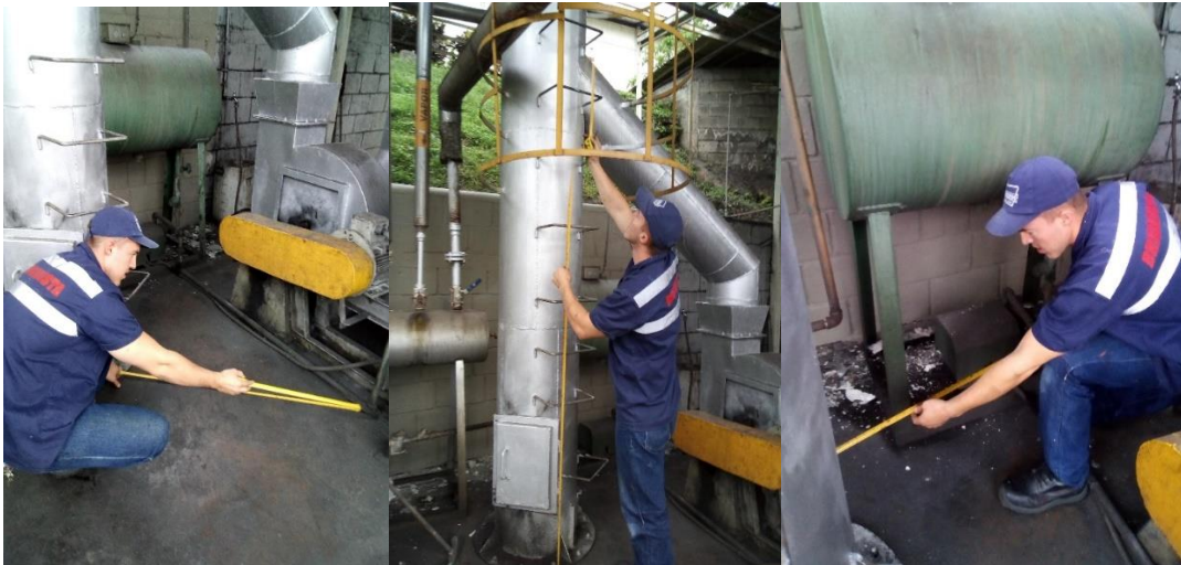
Figura 40: Medición de la tubería necesaria para la instalación de recuperador
