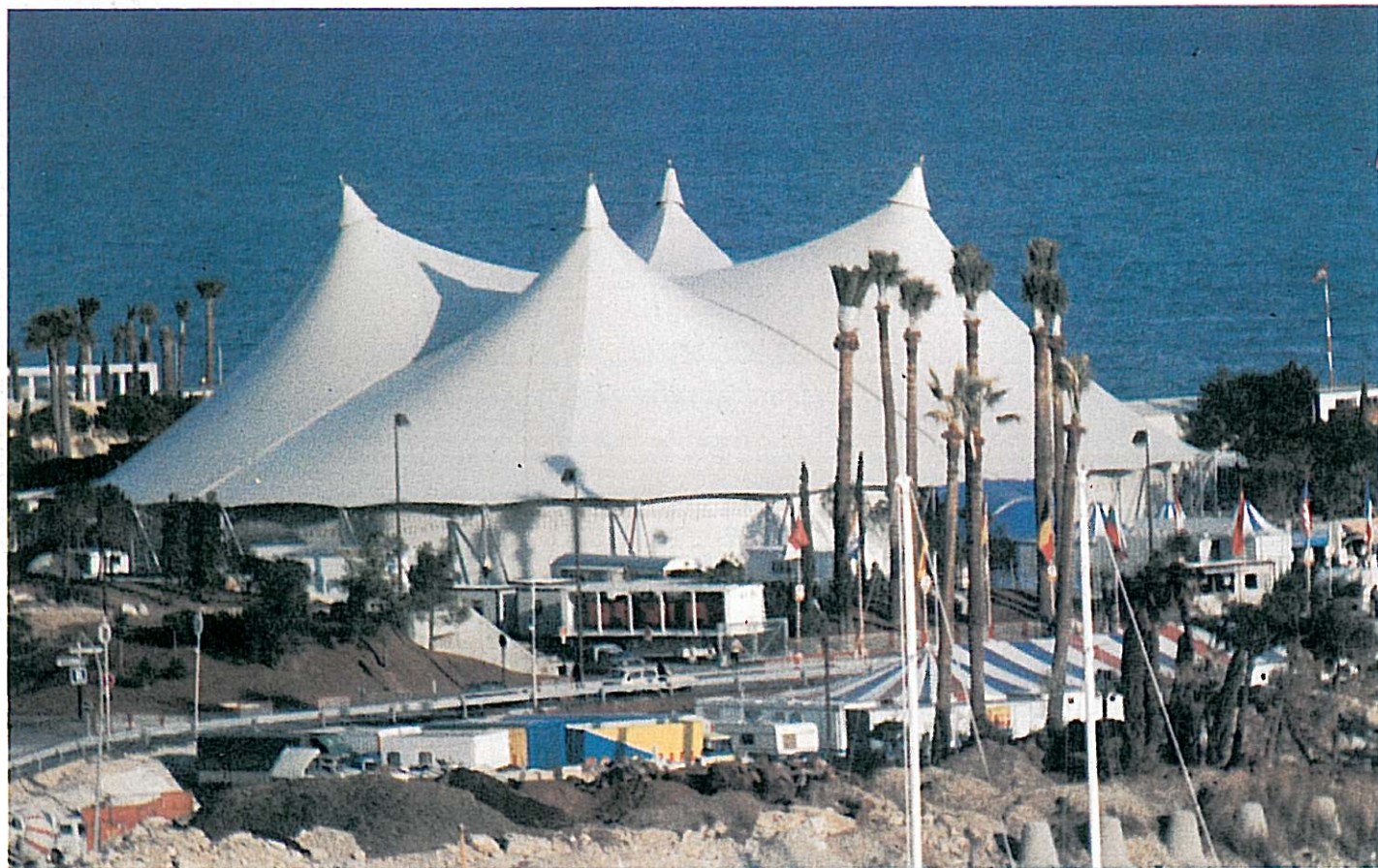
Principato di Monaco - La tensostruttura per il Festival Internazionale del Circo di Monte Carlo
