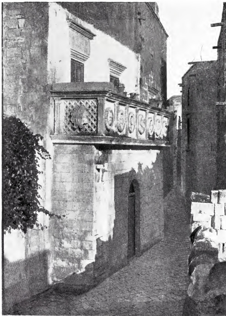
OTRANTO — BALCONE DI CASA CARROZZINI.
