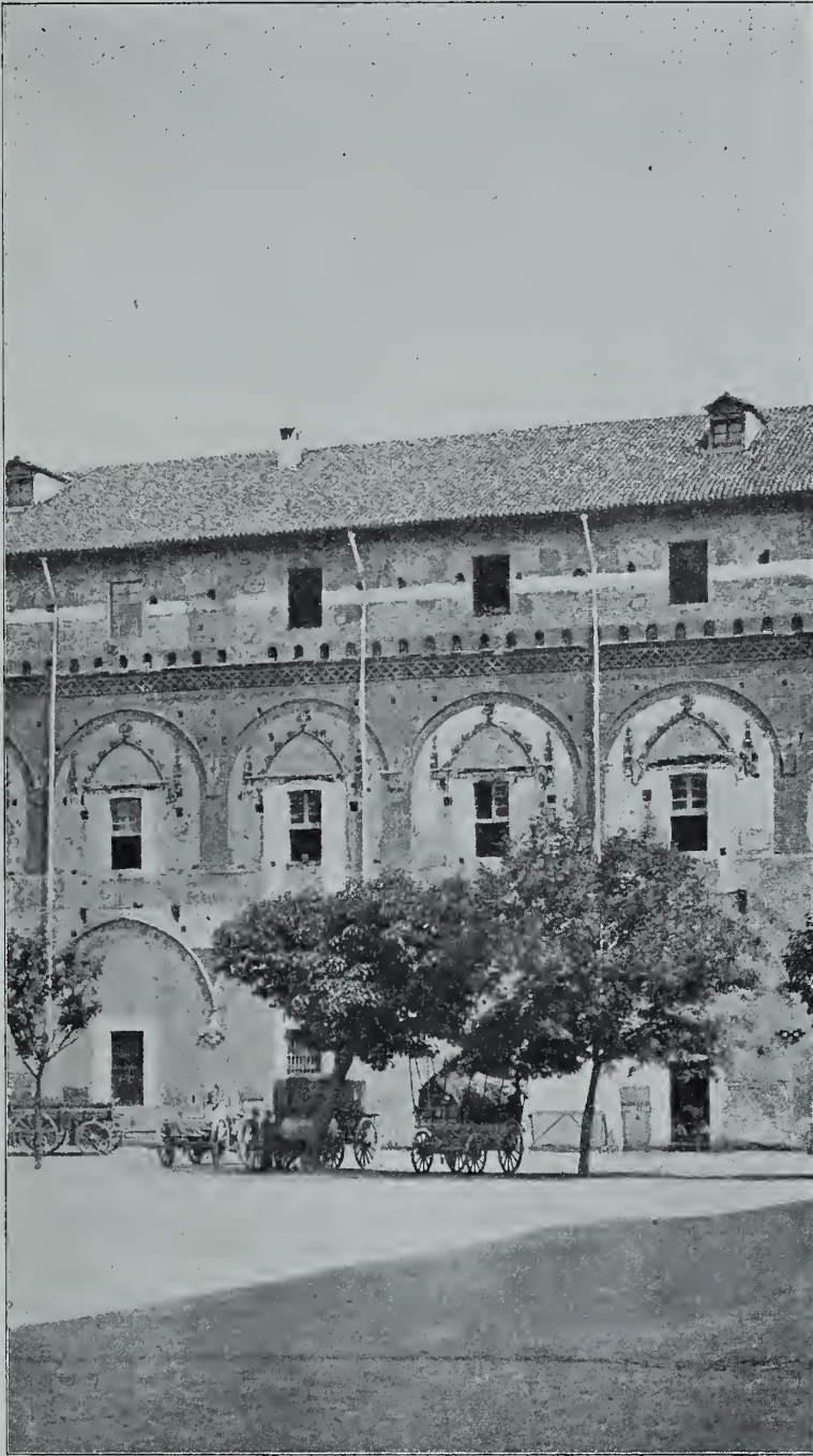
Fronte verso il cortile, colla disposizione delle finestre sostituite al loggiato, all'epoca di Gian Galeazzo.
