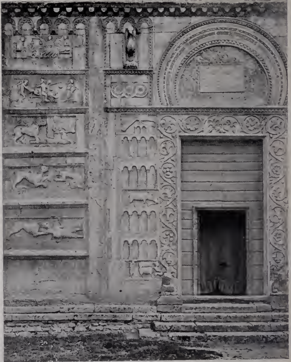
Fig. 797 — Spoleto, San Pietro. Particolari della facciata
