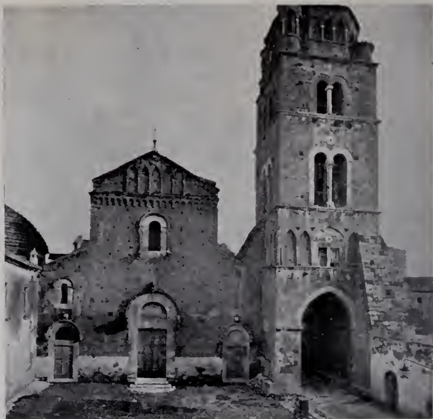
Fig. 475 -- Caserta Vecchia, Cattedrale. Prospetto
