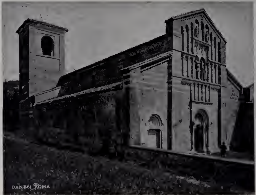
Fig. 69 — Vezzolano, Badia. Chiesa di Santa Maria
