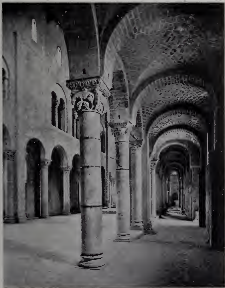
Fig. 736 — Siena (provincia di), Chiesa di Sant'Antimo. Interno
