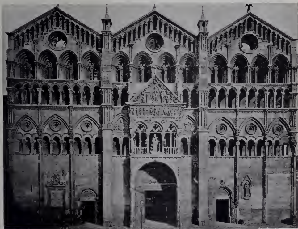
Fig. 22 — Ferrara, Facciata della cattedrale
