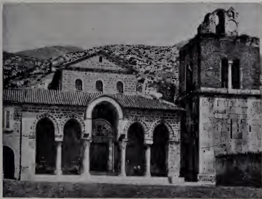
Fig. 474 — Sant'Angelo in Formis, Facciata della chiesa
