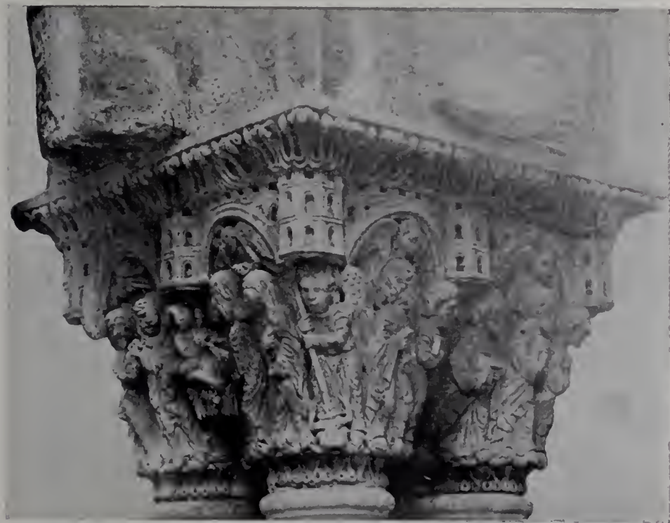
Fig. 591 — Monreale, Chiostro. Particolare del precedente fascio di colonne
