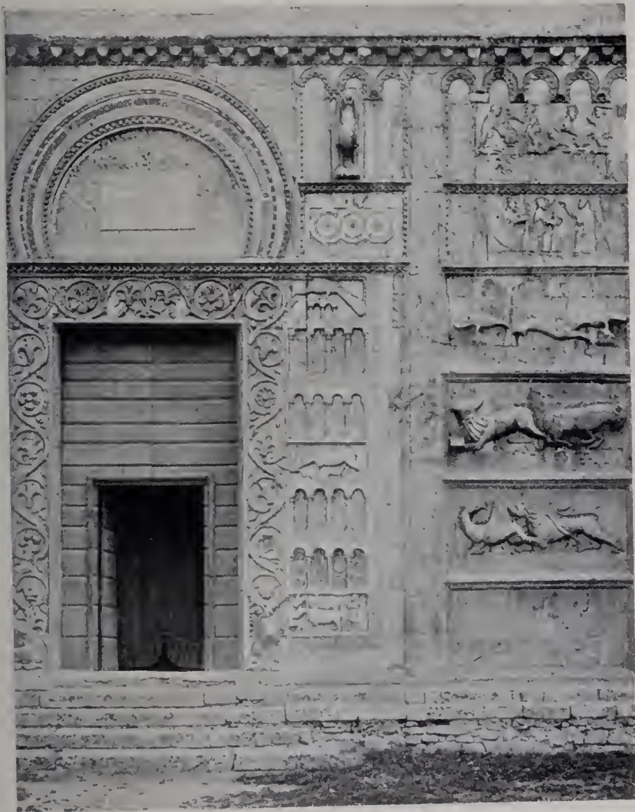
Fig. 796 — Spoleto, San Pietro. Particolari della facciata
