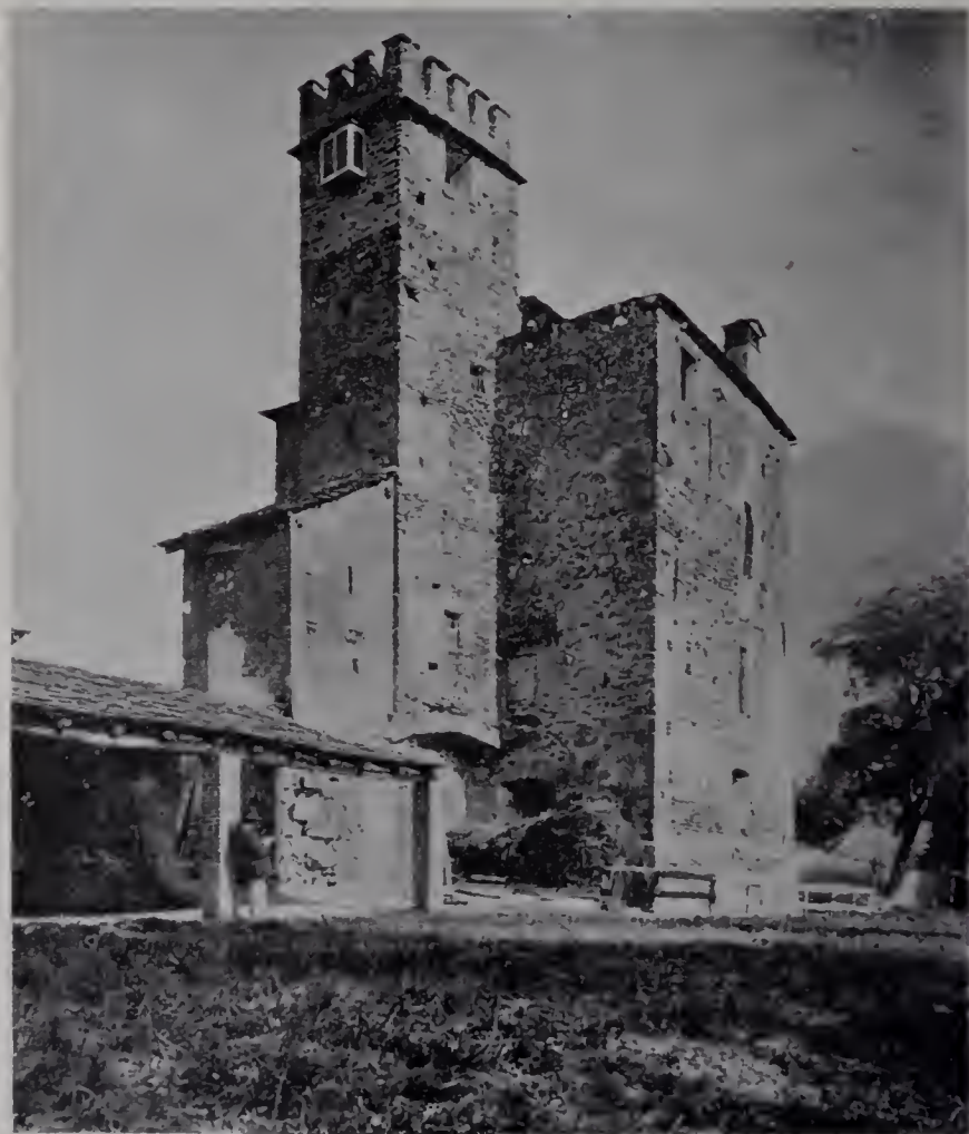
Fig. 50 — Aosta, Torre del Lebbroso
