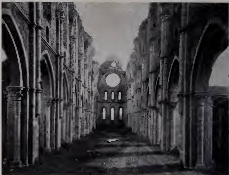
Fig. 773 — San Galgano (provincia di Lucca), Interno della chiesa
