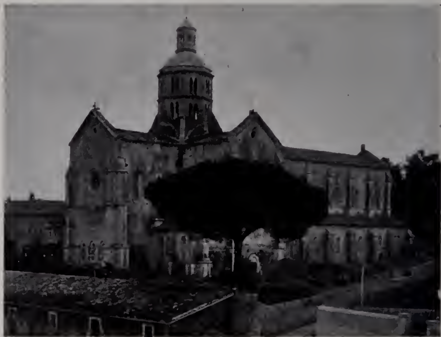
Fig. 720 — Fossanova, Chiesa della badia. Facciata
