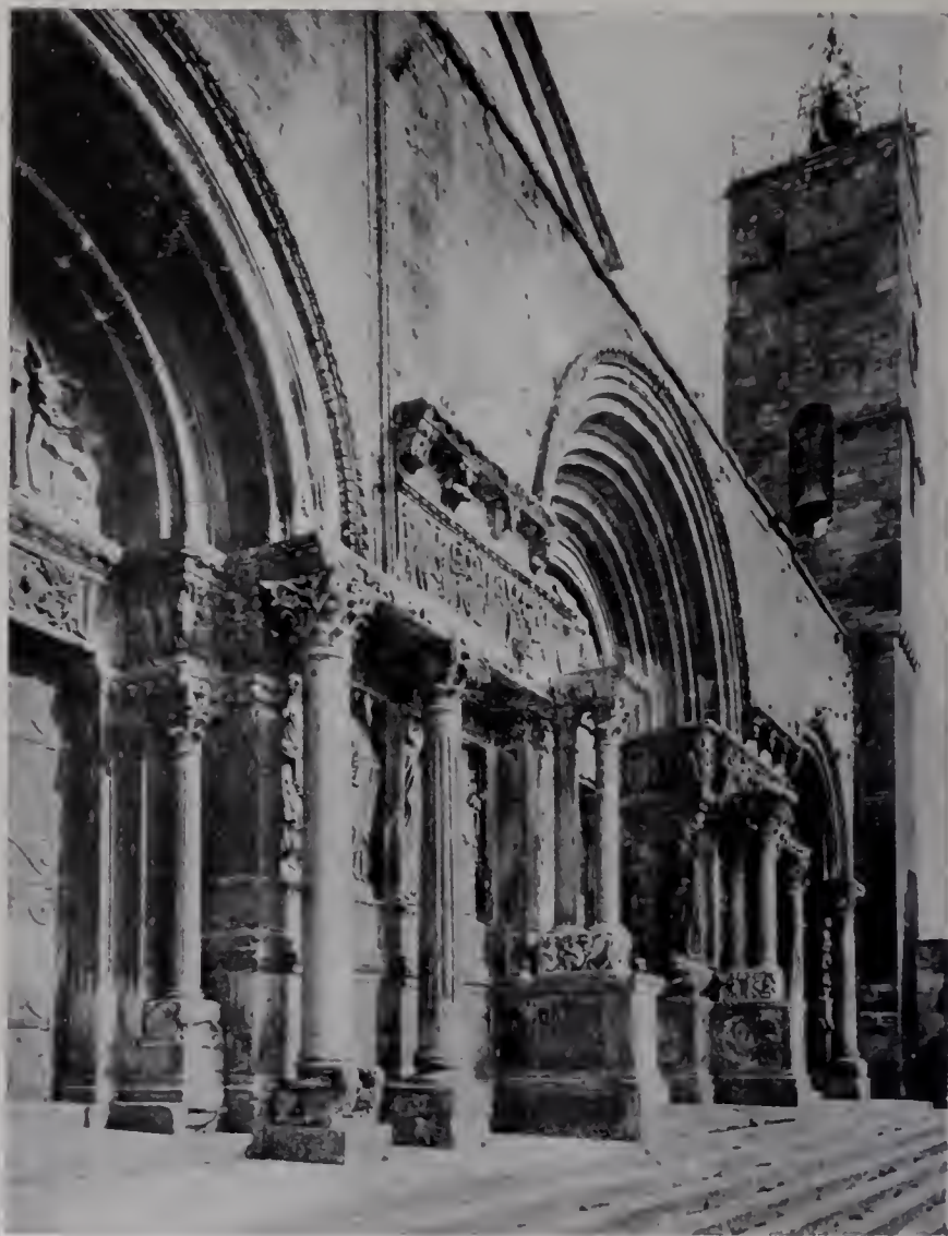
Fig. 279 — Saint-Gilles, Chiesa. Facciata
