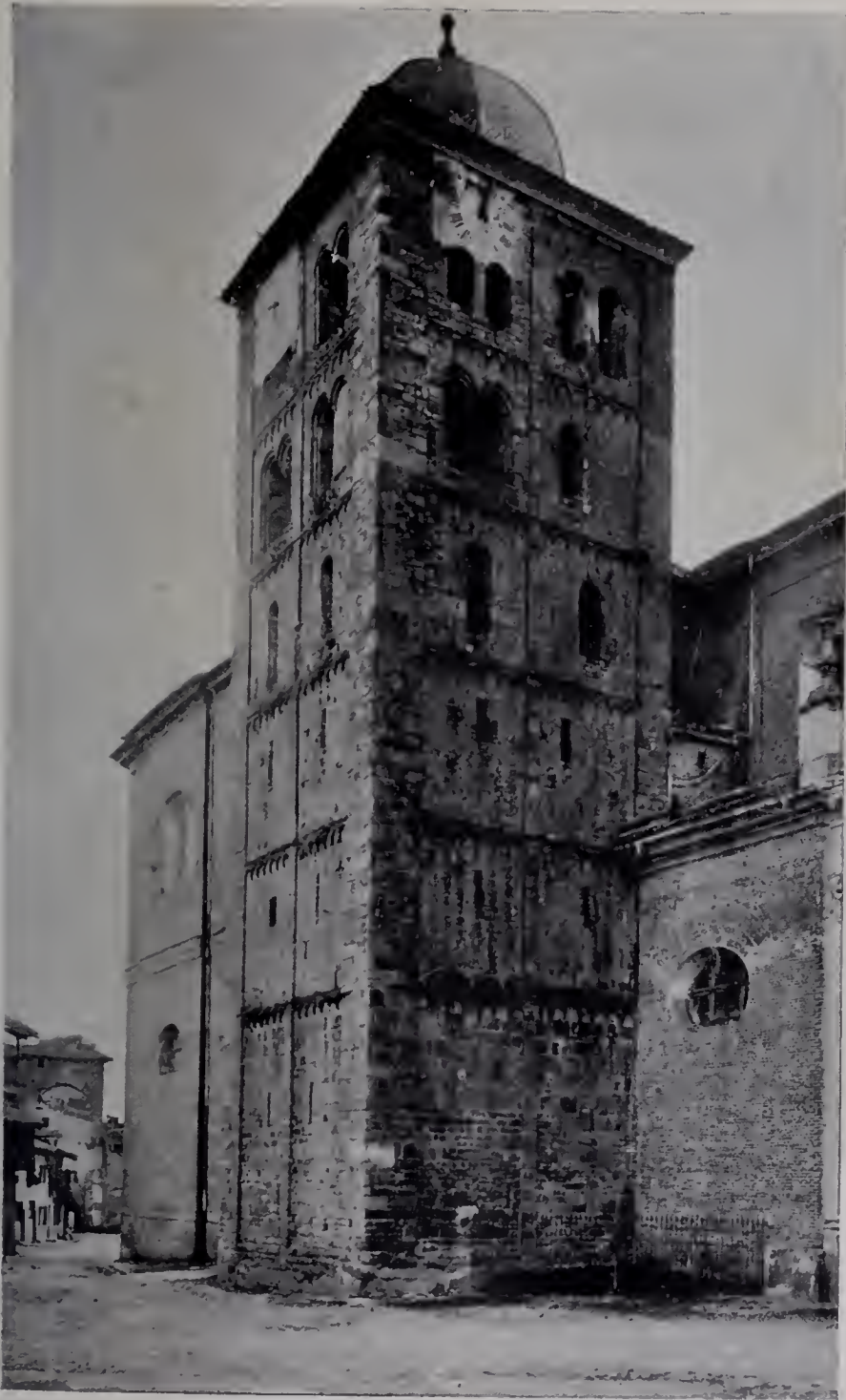
Fig. 53 — San Benigno (Piemonte). Campanile dell'abbazia
