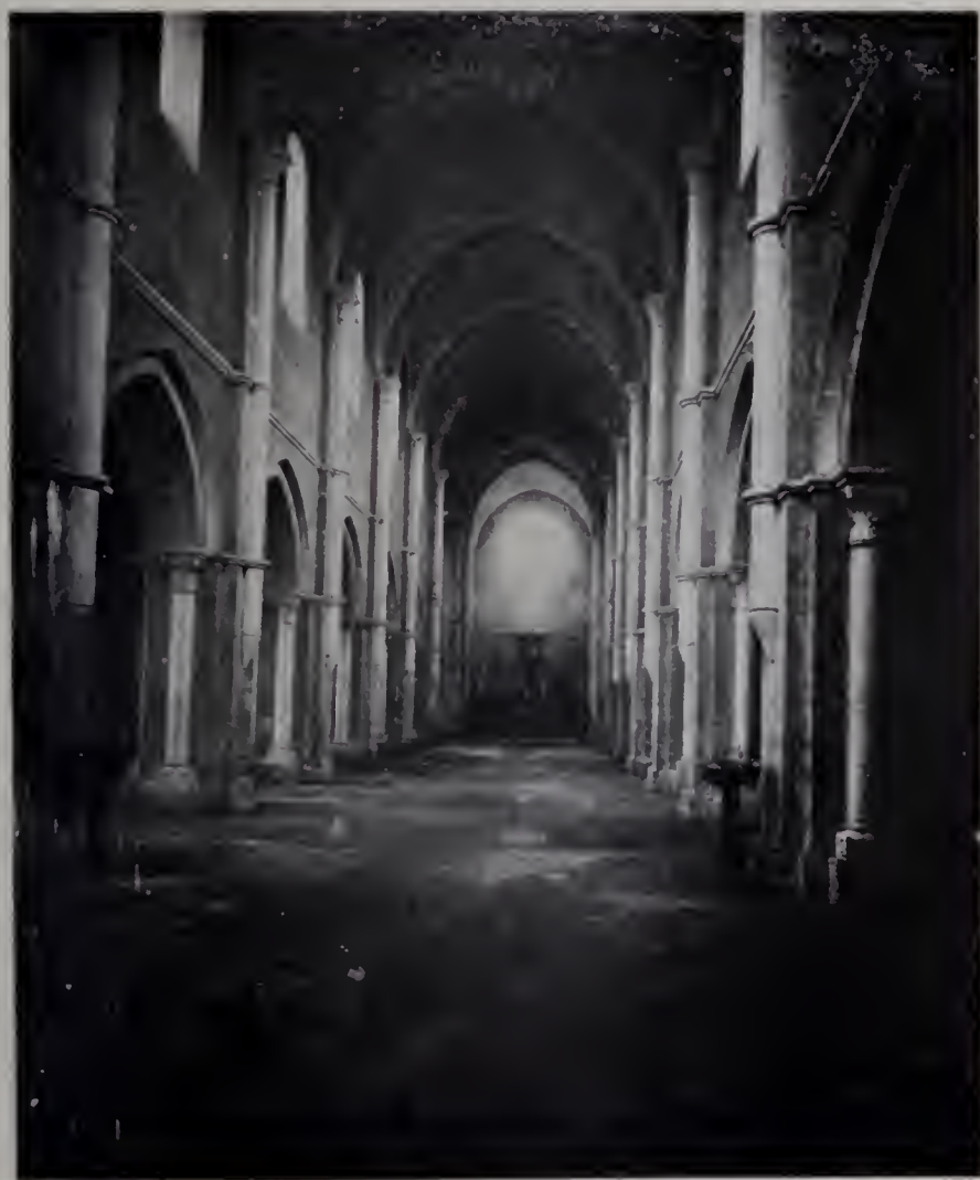
Fig. 721 — Fossanova, Chiesa della badia. Interno
