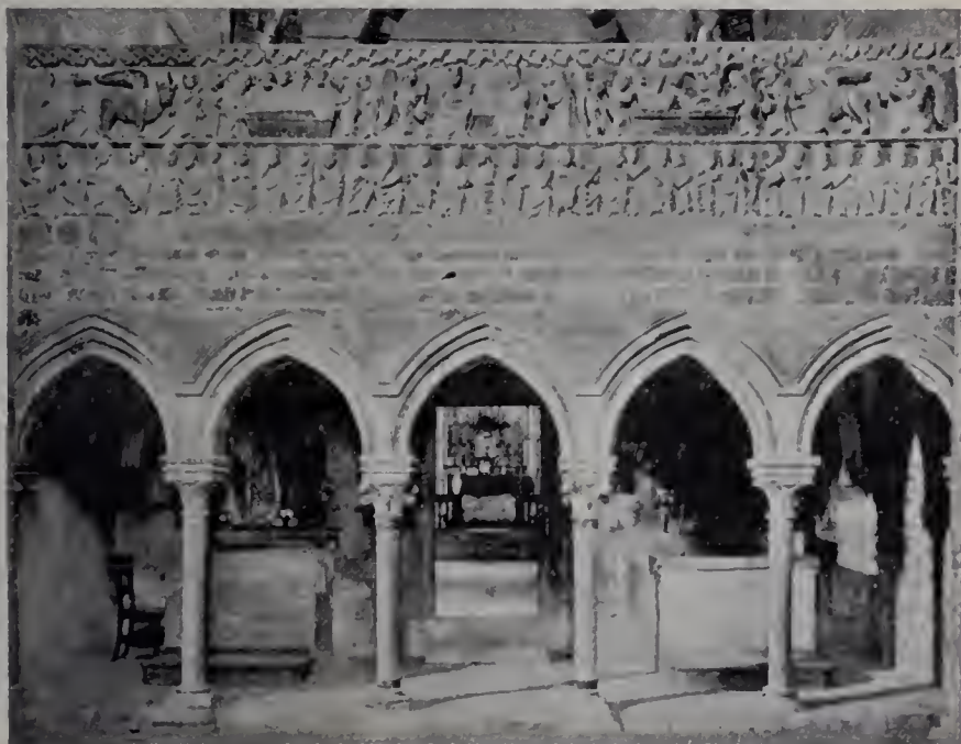
Fig. 72 — Vezzolano, Chiesa di Santa Maria. Tramezzo
