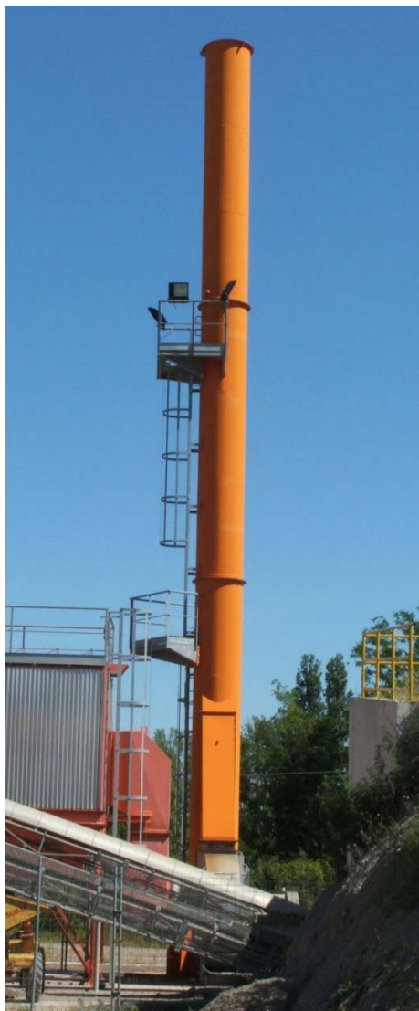
Fig. 15: scale fisse verticali a pioli, suddivisione tratte con ripiani intermedi.
