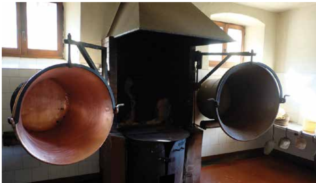
Le caldaie. Foto di Enea Gusmeroli.
