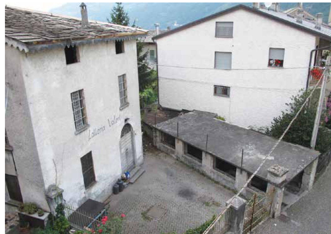
L'edificio della Lateria Valenti. Foto di Enea Gusmeroli.
