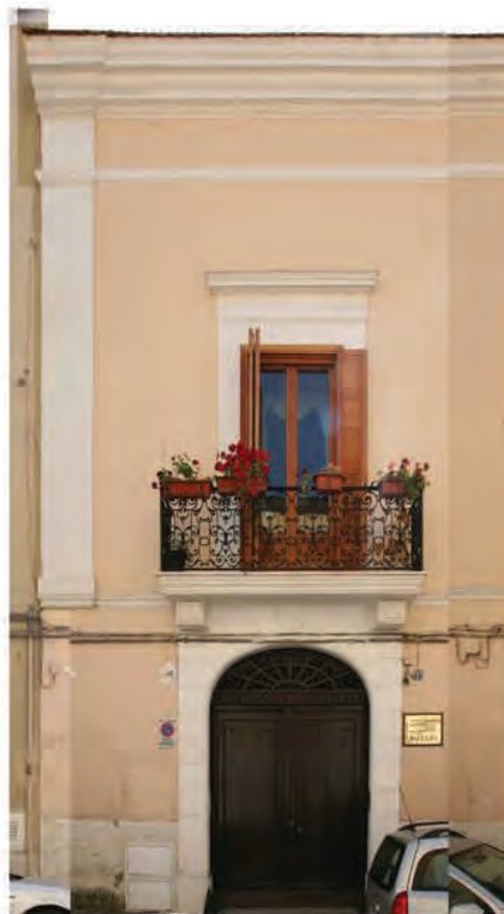
Particolare del sistema di portale con balcone sovrastante
