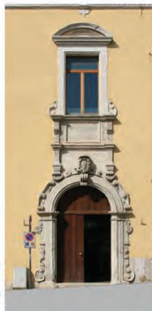
Particolare del sistema di portale con finestra sovrastante
