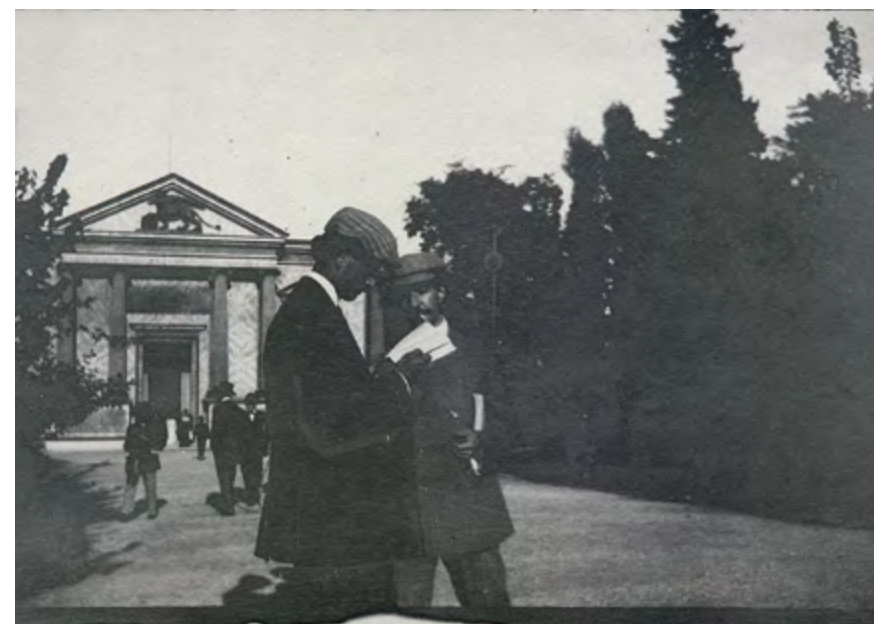
Collezione privata Due fotografie della facciata del palazzo dell'Esposizione di Venezia nel 1895 su progetto di Mario De Maria
