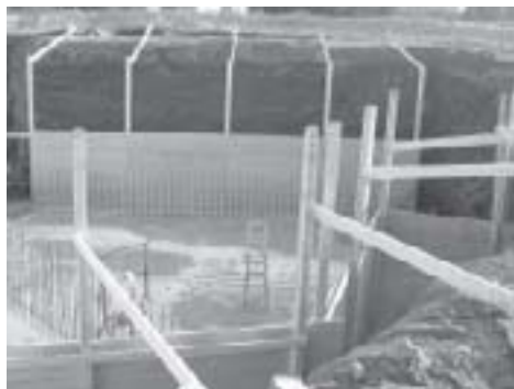
Scorcio di un cantiere
