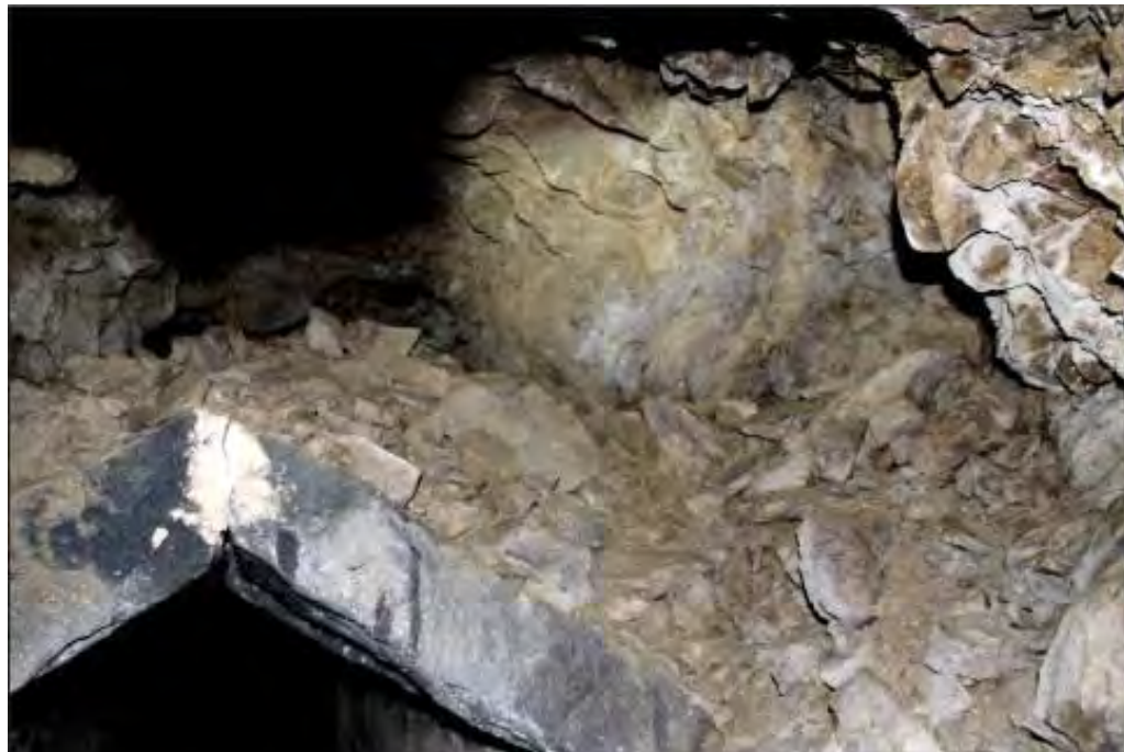
Figura 29. Alternanza arenaceo marnosa centi-decimetrica intensamente fratturata e caoticizzata del Flysch di Capo d'Orlando .
