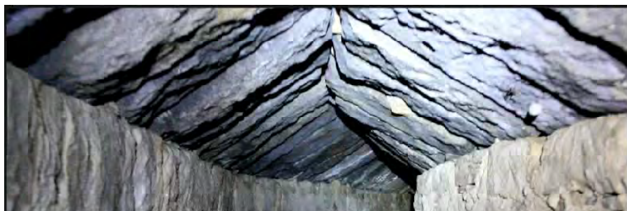
Figura 26. Particolare del tetto formato da blocchi lavici.
