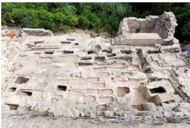
Figura 19. L'area delle navate centrale e settentrionale della Chiesa, distrutta dal terremoto del 1693, e la torre medievale, dopo la ripulitura (foto Giuseppe Barbagiovanni).
