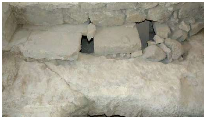
Figura 12. Lembi della pavimentazione secentesca USR 10 sulle fosse delle tombe, su cui poggia il muro di compagno di una delle arcate (foto Elisa Bonacini).
