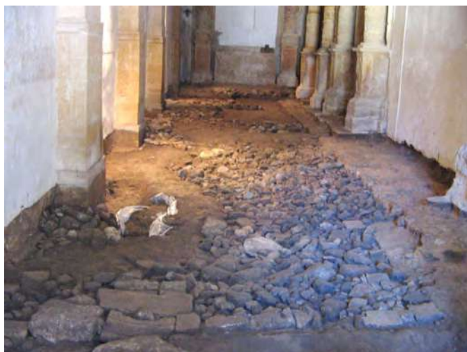
Figura 5. Vespaio di pietre e allettamento di terra al di sotto del pavimento settecentesco della Chiesa (foto Elisa Bonacini).
