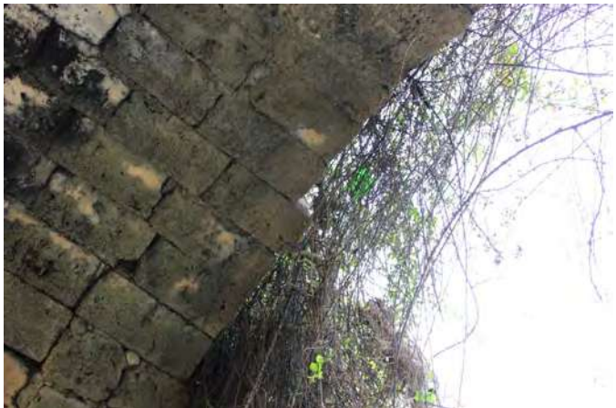
Figure 22 e 23. In alto lo stato d'abbandono del ponte di Carini coperto da sterpaglie, rifiuti e spazzatura. In basso un particolare dei conci dell'arco a tutto sesto probabile oggetto di restauro.
