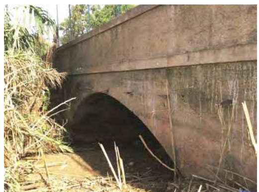
Figura 11. Il ponte Fondachello è ormai inglobato nella struttura del ponte più recente in c.c.a. della SS 113 (tra il km 241 ed il 242) che lo ha fatto scomparire. Nel cerchio rosso (a lato) si nota un concio originale della volta inglobato nella struttura nuova.
