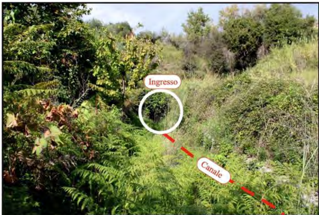
Figura 23. L'ingresso della galleria drenante.
