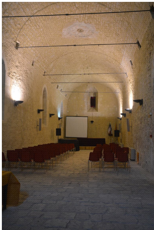
Figura 21. Visione di un pilastro della copertura a crociera, di impronta gotica, nella sala al primo piano, del palazzo medievale di Favara, posta a sud della cappella (foto di Filippo Sciara).
