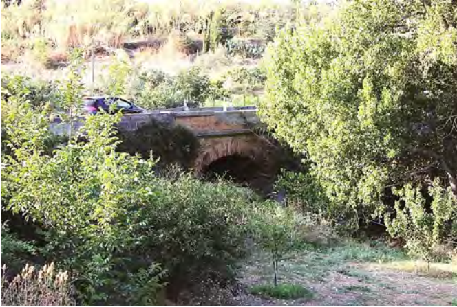
Figura 25. Il ponte vecchio di Nocella ormai “tombato” nel nuovo.
