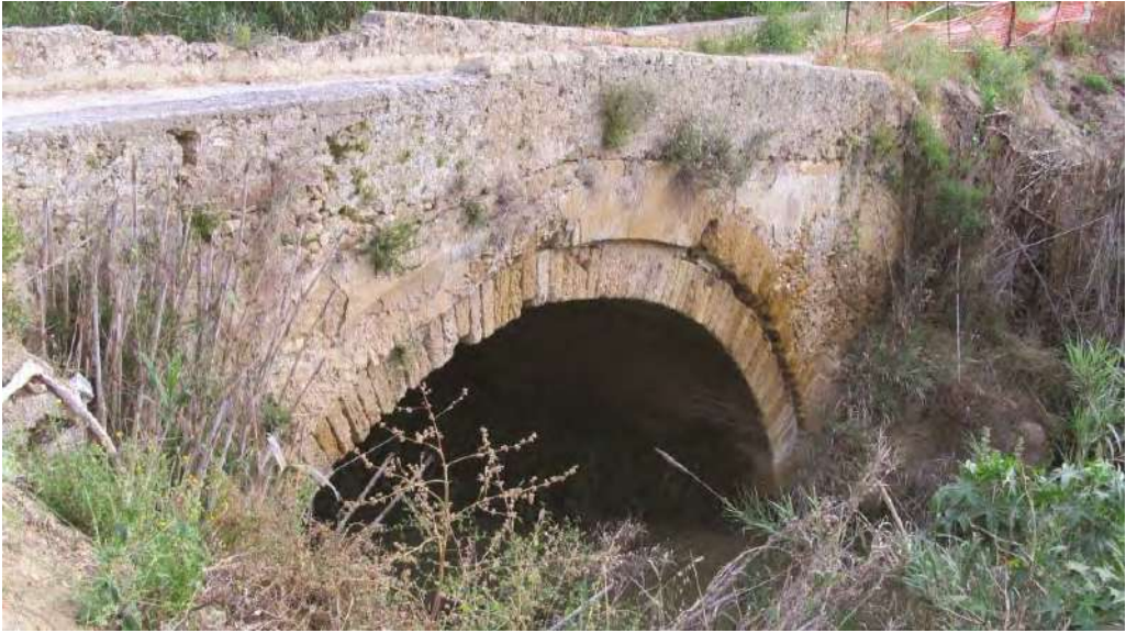
Figure 27 e 28. Sopra: la ricostruzione grafica del ponte prima dell'approssimativo restauro. Sotto: il ponte prima del restauro. Si nota chiaramente l'arco aggiunto nel XVIII secolo a sostegno dell'arcata in pietra ed il parapetto in c.c.a..
