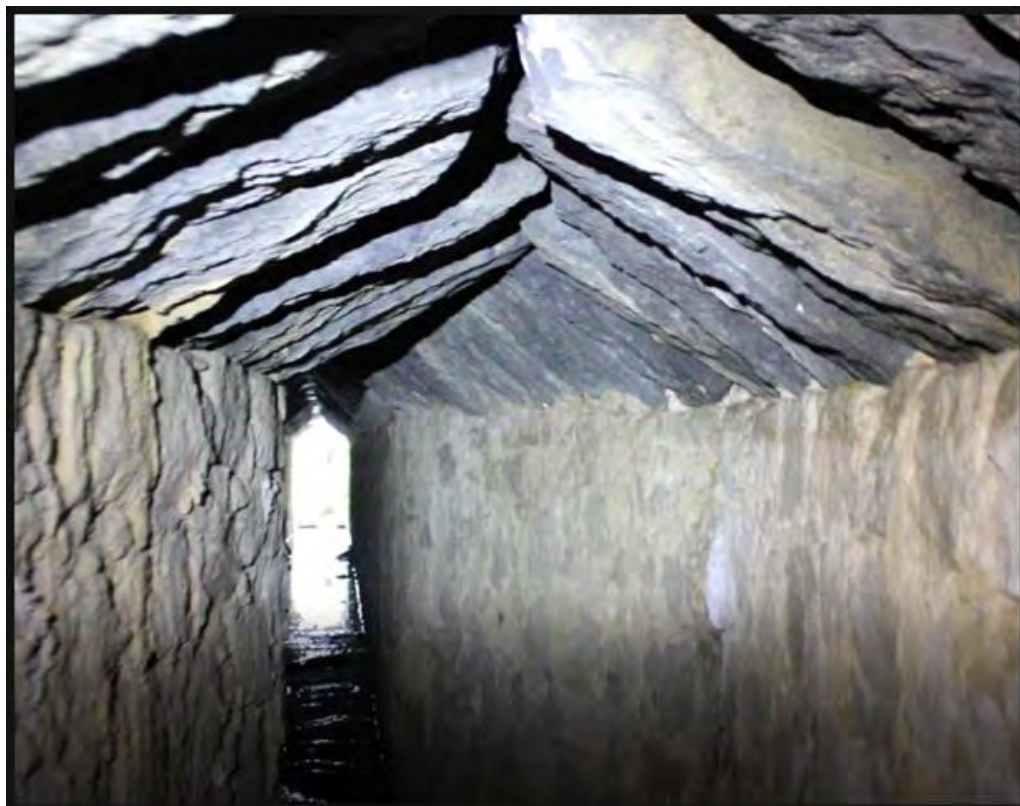
Figura 21. Dentro la galleria drenante.
