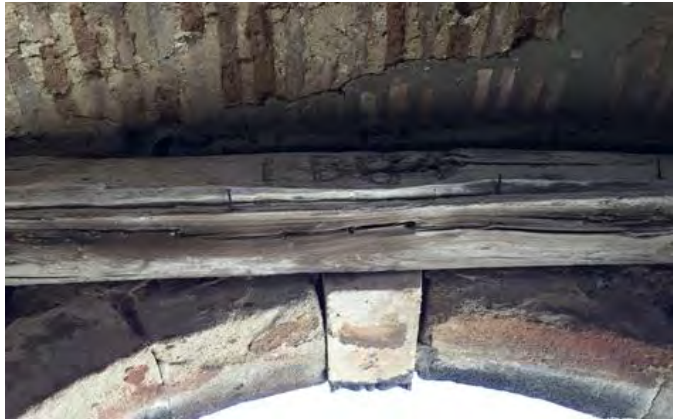
Figura 4. Particolare della trave lignea interna all'ingresso del complesso monastico, con data.
