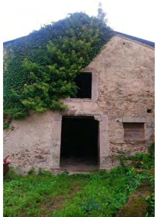
Figura 26. Facciata della chiesa di Santa Maria de Scalis, Massa San Nicola.
