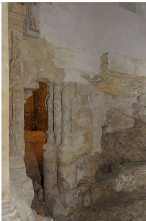
Figura 11. Struttura muraria USM 63 decorata con colonnine, del XV-XVI secolo, rinvenuta rimuovendo il muro di fondo di chiusura della Cappella di Santa Maria La Stella (foto Giuseppe Barbagiovanni).
