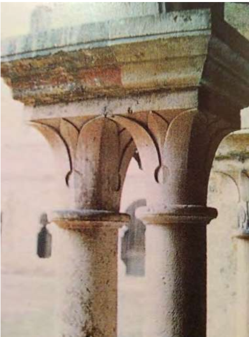
Figura 24. Abbazia cisterciense di Fontenay (Borgogna). Capitelli del chiostro decorati con foglie ovali-appuntite, lisce, aderenti alla campana e con nervatura mediana evidente.
