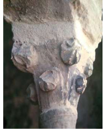
Figura 30. Capitello di una bifora del primo piano, lato nord, del palazzo di Favara. Decorazione con due giri di foglie lisce a crochet , di tipo semplice (foto di Filippo Sciara).
