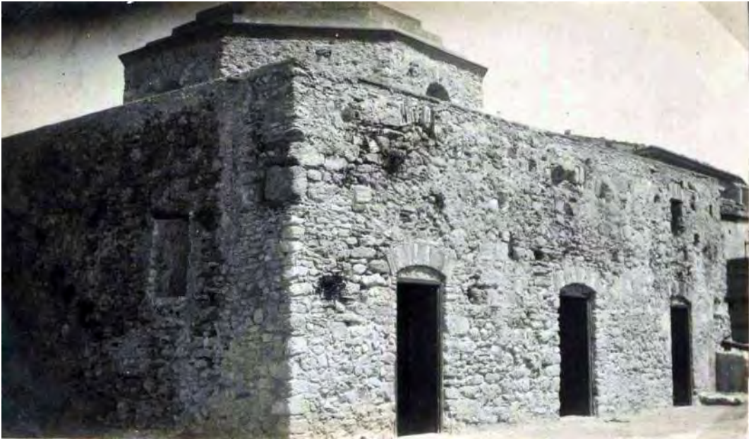
Figura 24. La chiesa durante i lavori che furono realizzati da Francesco Valenti (Di BENNARDO 2017, p. 143).
