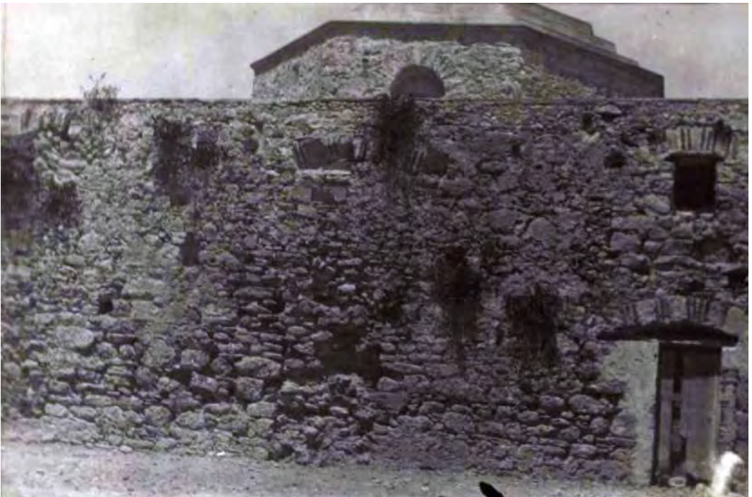
Figura 20. Il prospetto orientale della chiesa prima degli interventi che furono realizzati da Francesco Valenti (DI BENNARDO 2017, p. 137).
