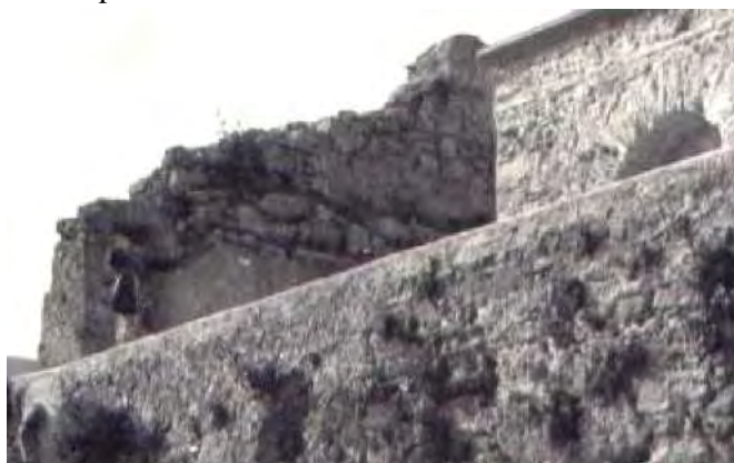
Figura 39. La parte superiore del prospetto ovest della chiesa (ingrandimento della figura 18), prima degli interventi di F. Valenti, nella quale risaltano numerosi conci grossolanamente squadrati.
