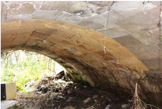
Figura 20. Il ponte della Madonna di Carini. L'arcata originale (in fondo) è affiancata da un'arcata più recente (XIX secolo?). Il fondo del torrente si è visibilmente innalzato e la metà della volta, probabilmente a tutto sesto, è nascosta dai detriti trasportati dall'acqua.
