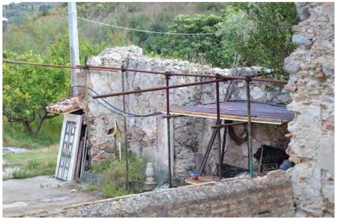
Figura 5. Tracce del muro destro dell'edificio ecclesiastico.
