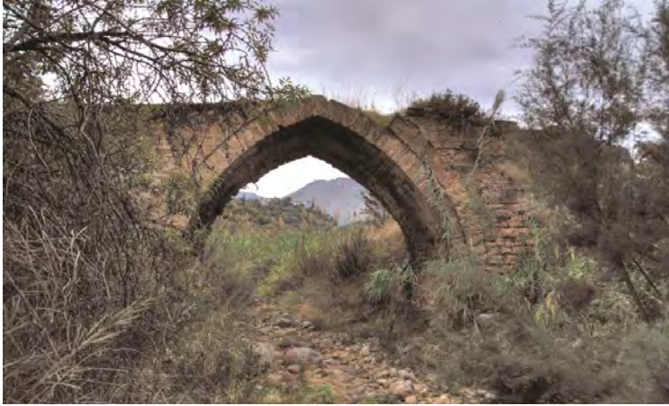
Figura 9. Il bell'arco gotico a doppia ghiera del ponte di San Michele inserito nel XIII secolo.
