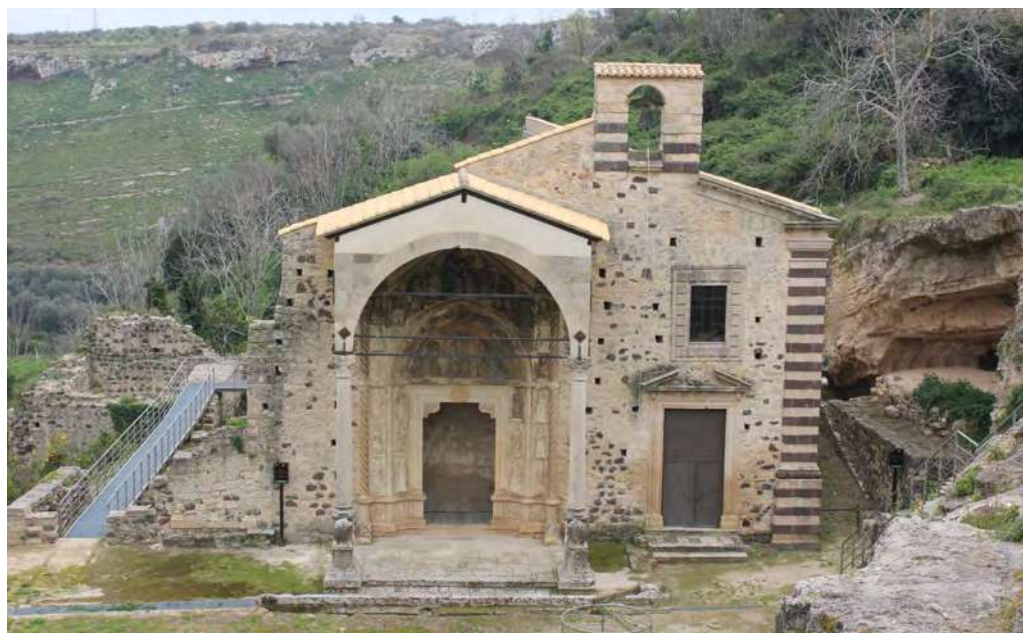
Figura 1. La Chiesa di Santa Maria La Vetere a Militello Val di Catania dopo l'intervento del 2009 (foto Antonio Pico).
