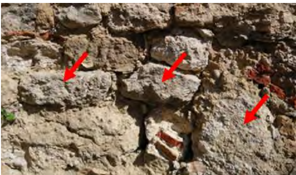
Figure 36, 37, 38. Alcuni grandi e piccoli conci grossolanamente squadrati che caratterizzano la parte a faccia vista del muro di isolamento.
