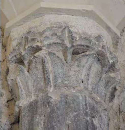
Figura 22. Capitello della sala coperta a crociera, del palazzo medievale di Favara. Si notino, nel giro inferiore, le quattro foglie di forma ovale-appuntita, ripiegate verso la punta, con margine sporgente e con nervatura mediana molto rilevata, di impronta artistica cisterciense (foto di Filippo Sciara).
