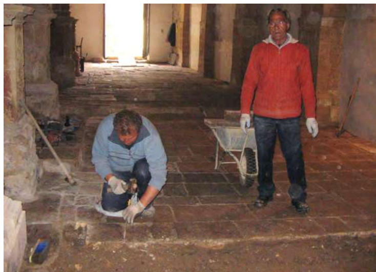
Figura 4. Rimozione del pavimento settecentesco della Chiesa (foto Elisa Bonacini).
