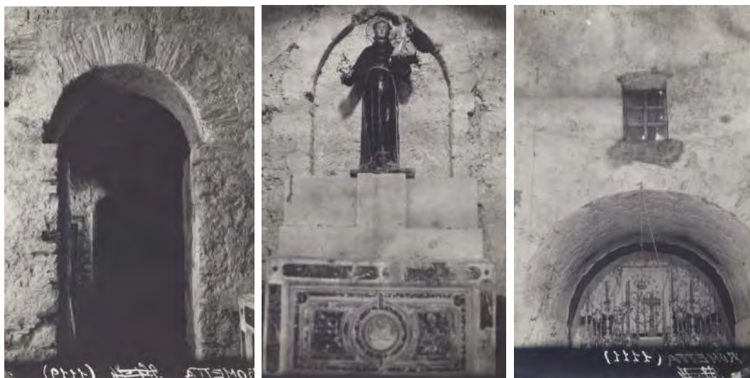
Figure 21, 22, 23. Da sinistra: un arco a testa di chiodo dopo la stonacatura, l'altare dedicato a S. Antonino prima dei lavori interni e una delle finestre della sala cupolata (SOPRINTENDENZA MESSINA, N. 56.2).
