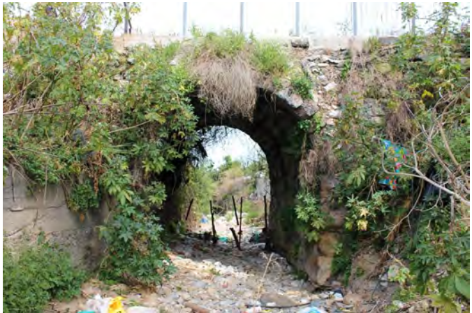
Figure 22 e 23. In alto lo stato d'abbandono del ponte di Carini coperto da sterpaglie, rifiuti e spazzatura. In basso un particolare dei conci dell'arco a tutto sesto probabile oggetto di restauro.
