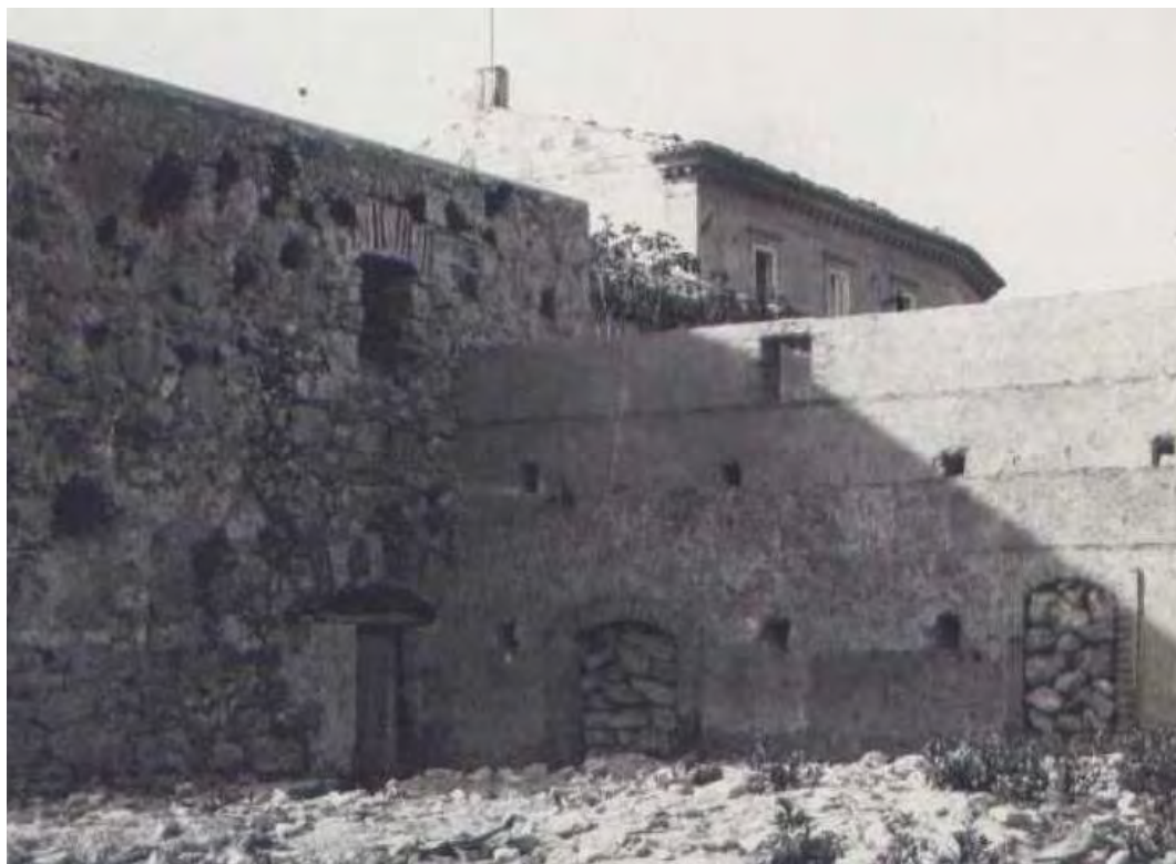
Figura 12. 1913 circa. Le opere abusive che furono addossate al prospetto orientale della chiesa (SOPRINTENDENZA MESSINA, N. 56.2).
