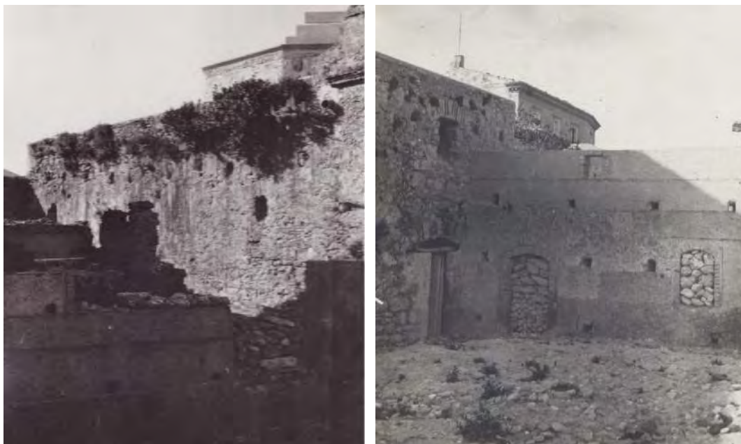
Figure 13 e 14. 1913 circa. Le opere che furono realizzate da Giuseppe Pollicino a nord e a est (SOPRINTENDENZA MESSINA, N. 56.2). La fotografia a sinistra documenta la demolizione dell'antica casa che era presente nell'area.
