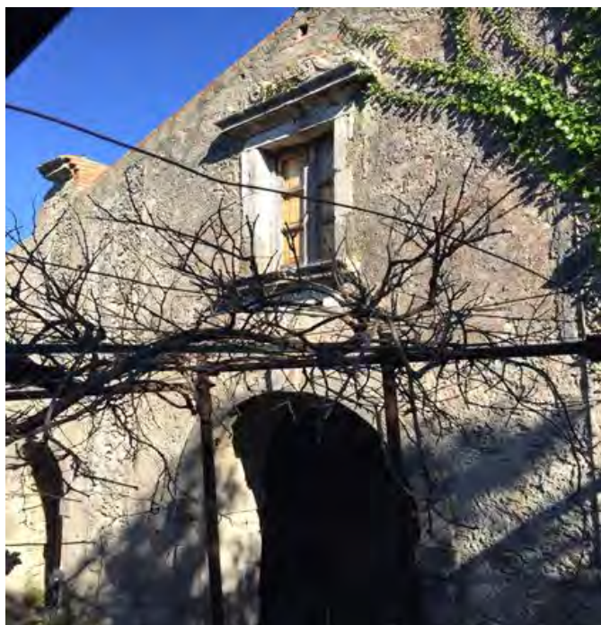
Figura 1. Facciata principale della Chiesa di S. Maria dell'Austro, Massa San Giorgio.
