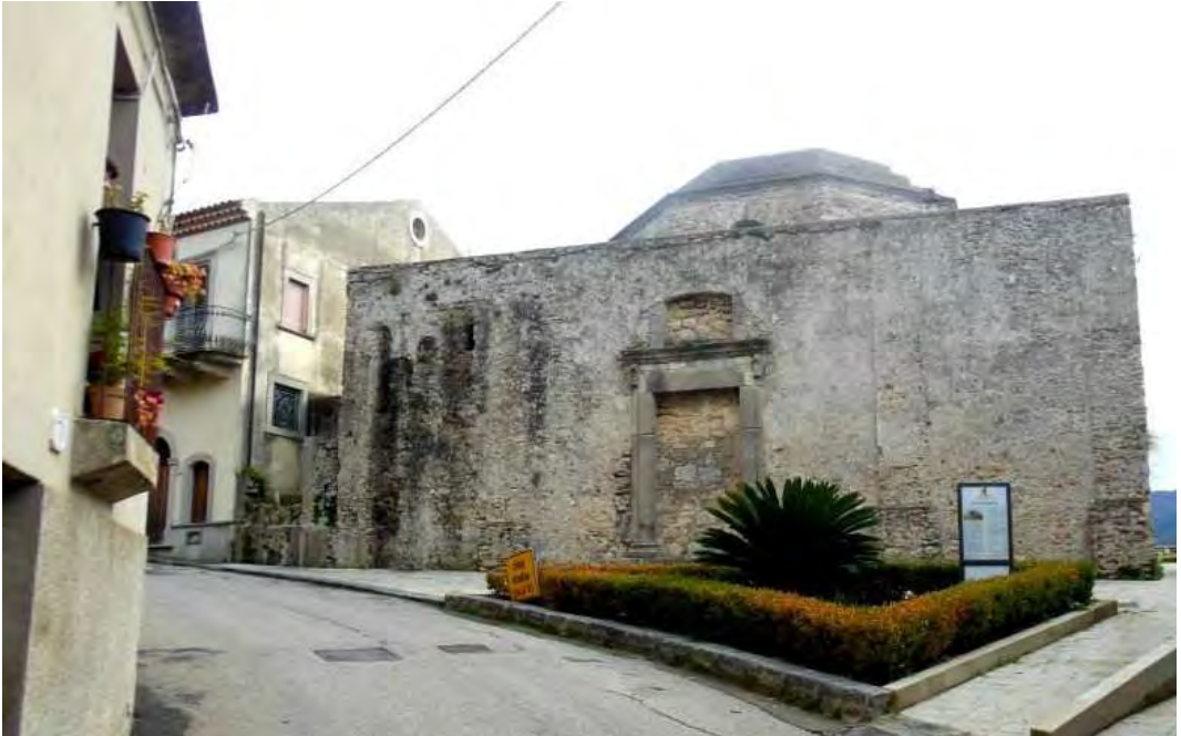
Figura 1. Il prospetto occidentale, sulla via Ardizzone, della chiesa Santa Maria dei Cerei (definita nei secoli anche Badia antica, della Candelora e Gesù e Maria ).
