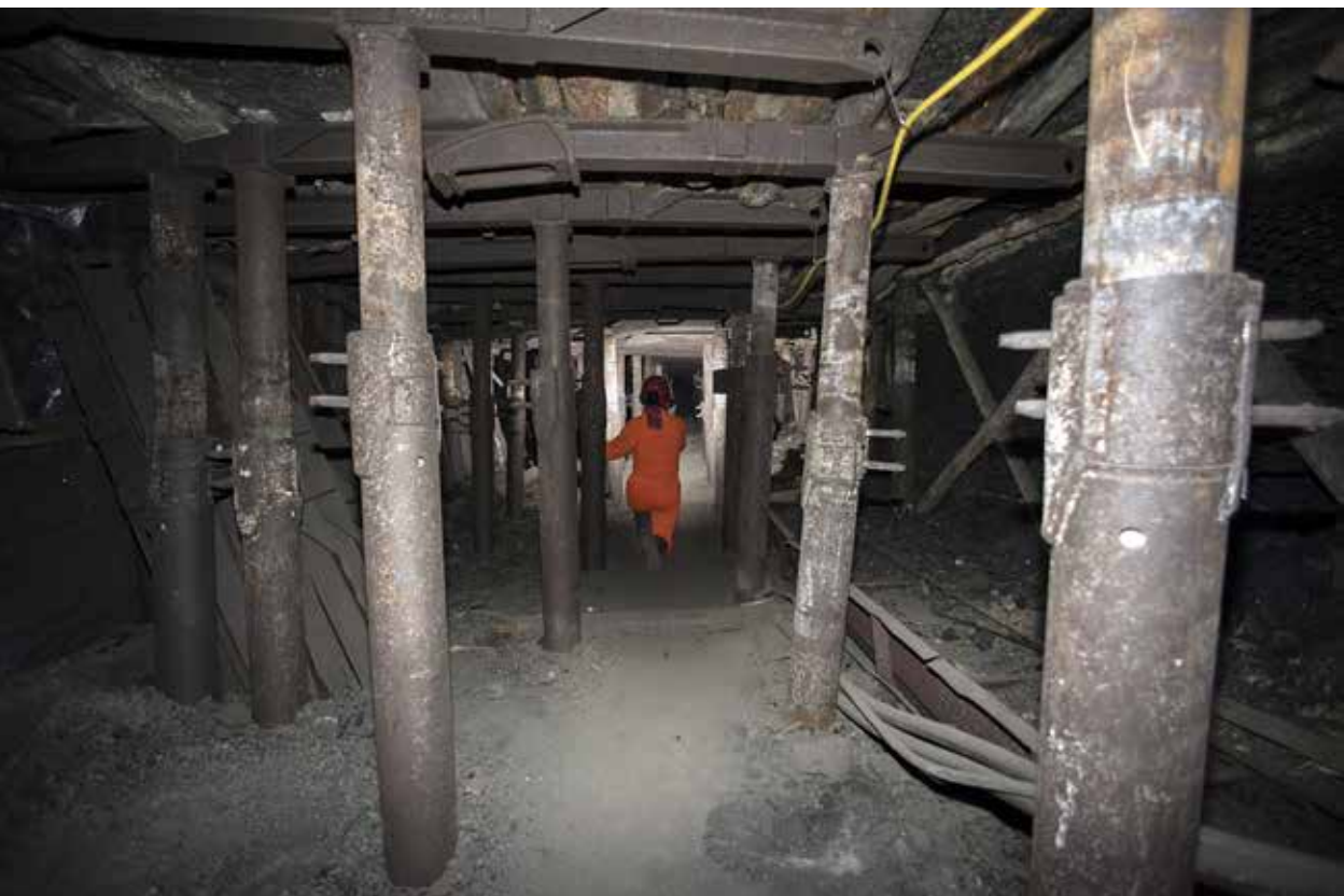
Kopalnia Guido: cantiere di estrazione con butte metalliche. (foto G. Belvederi).
