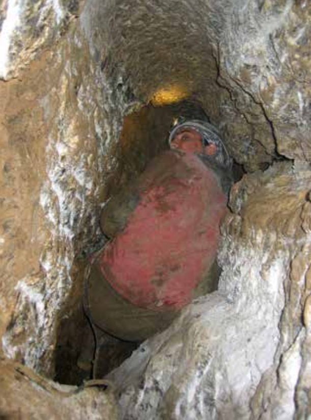
Operazioni di demolizione con trapano a filo (foto M. Dondi).
