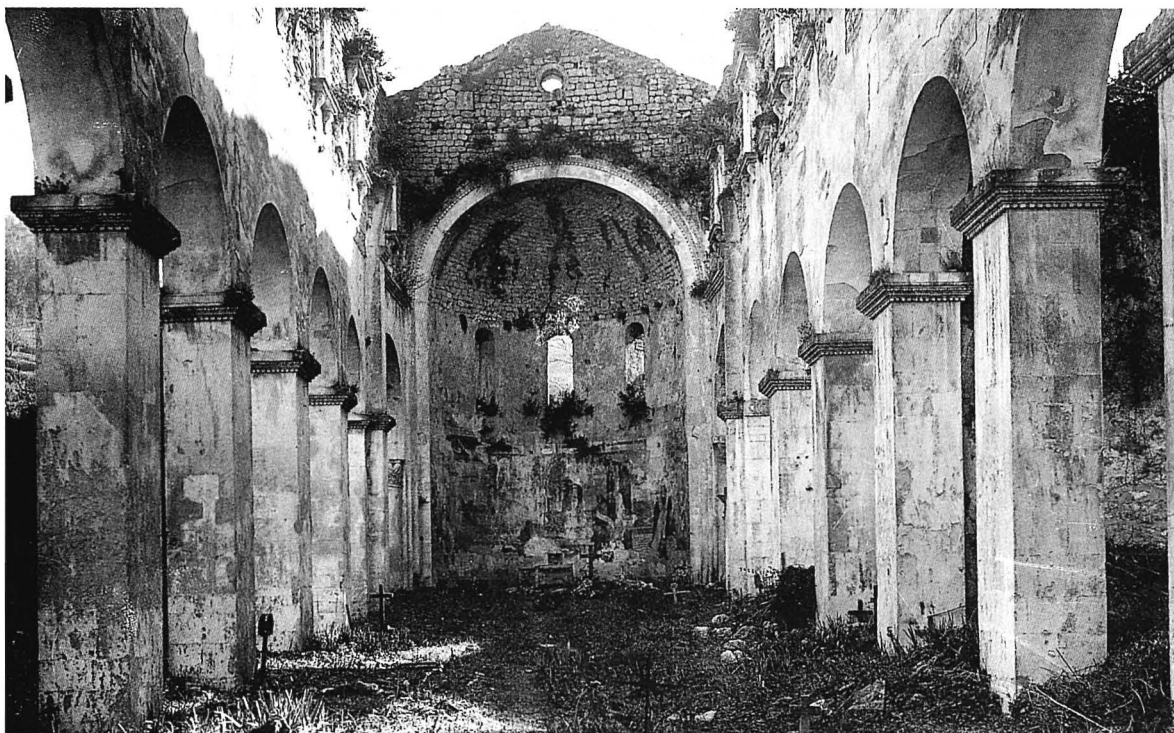
FIG. 1 - SERRAMONACESCA, Chiesa abbaziale di S. Liberatore alla Maiella: Veduta dell'interno della prima del restauro.
