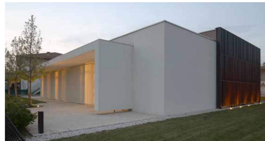
vista da sud-est; a partire dal tramonto inizia a disvelarsi la presenza delle aperture retrostanti il sistema frangisole e anti intrusione
