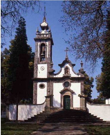
Foto 46 - Capela de São Bento da Porta Aberta
