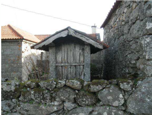
Foto 56 - Espigueiro de granito e madeira
