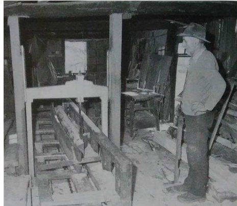
Figura 54 - Aspecto geral de um engenho em Padornelo
