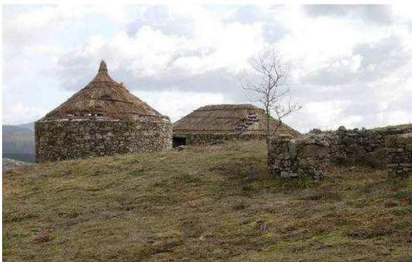
Foto 89 - Casas com telhado em colmo – Trilho Chã da Burra
