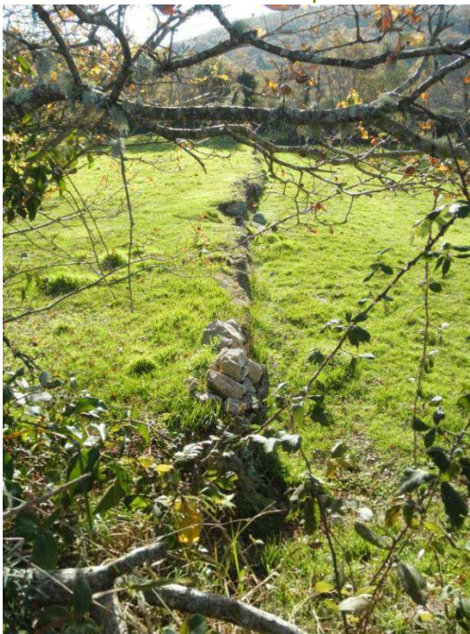
Foto 62 - Muros de suporte
