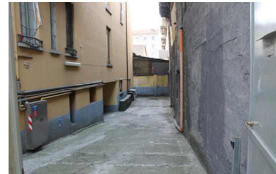
1. Vista dell'ingresso del cortile della palazzina in via Merano 20
