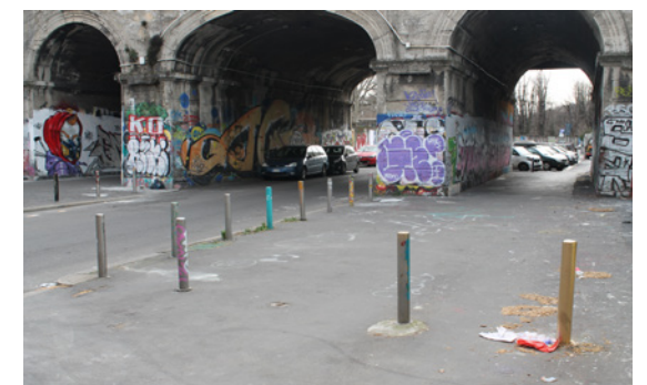
7. Vista del sottopasso che collega via Pontano a via Felicità Morando
