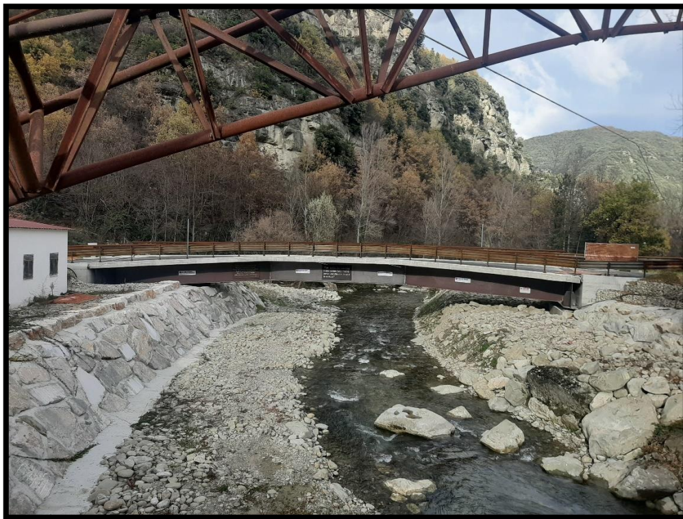
Foto n. 5: particolare del nuovo ponte
