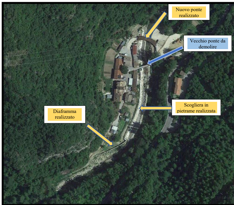
Fig. 20 – foto aerea con indicazione delle opere realizzate e da realizzare
