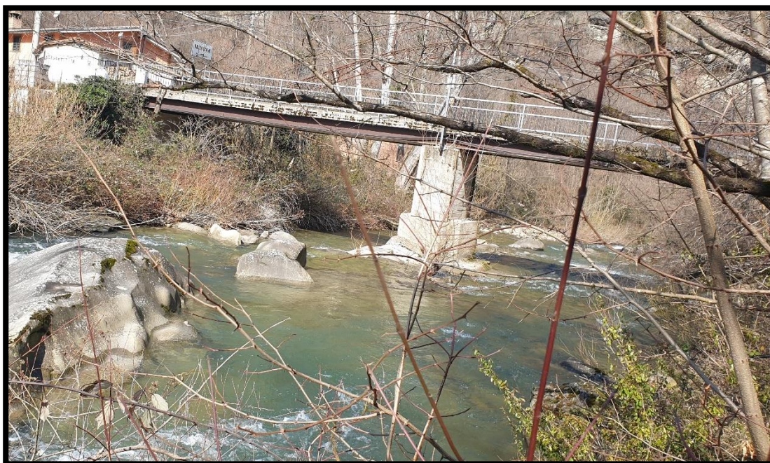
Foto n. 7 – vecchio ponte da demolire
