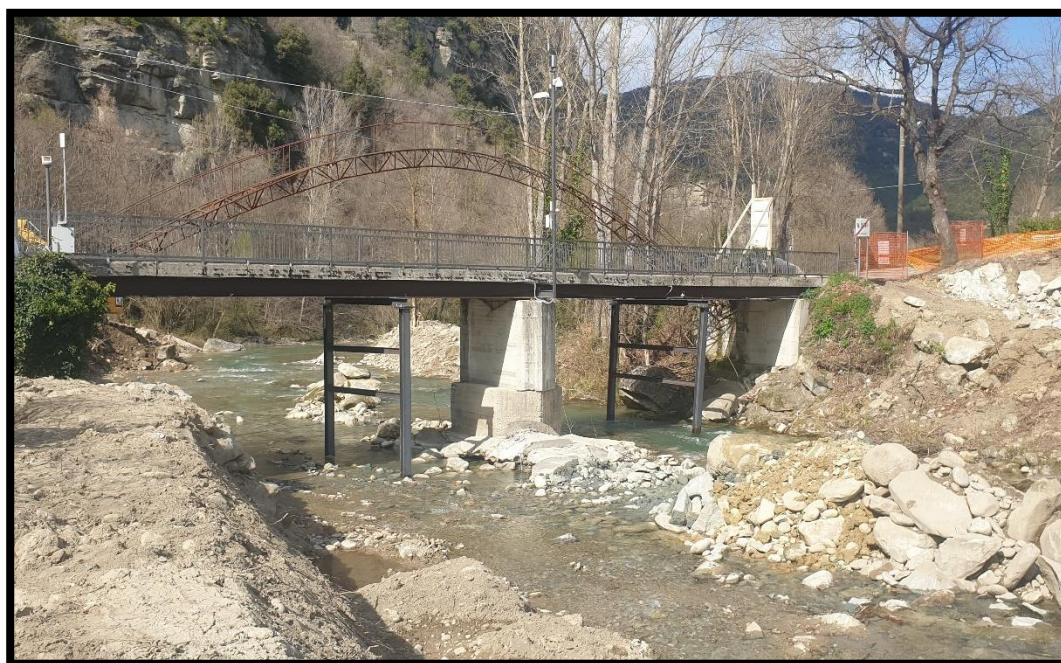
Foto n. 8 – vecchio ponte da demolire con evidenziati gli interventi di carattere provvisorio eseguiti, attraverso l'inserimento di due telai, durante i lavori di difesa sponale.
