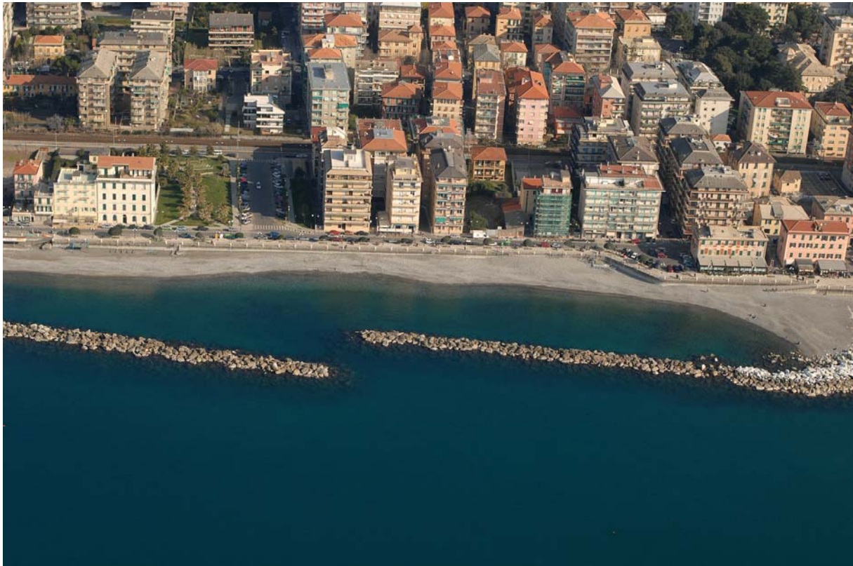
Figura 3.2 Le barriere parallele di Chiavari (foto prospettiche R.L. - 2008)
