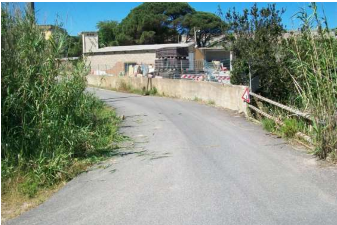
Figura 5 - Ponte ID_45 su strada comunale
