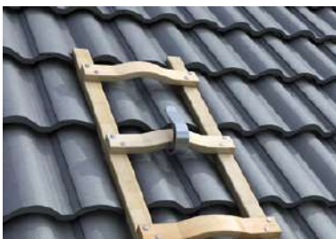
Abb. 66 Einhängen der Dachauflegeleiter
