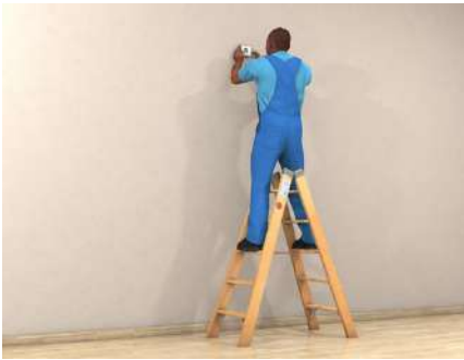
Abb. 56 Sicherer Stand auf einer beidseitig begehbaren Stufenstehleiter
