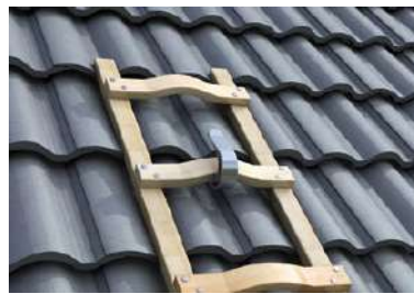
Fig. 66 Accrocher l'échelle de support de toit
