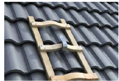
Fig. 66 Appendere la scaletta di sostegno del tetto
