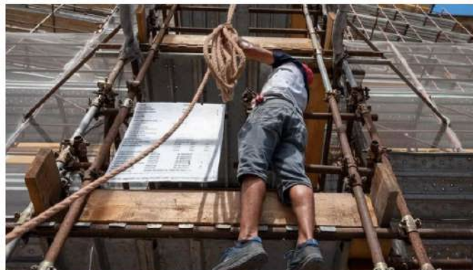
▲ Un operaio al lavoro in un cantiere di via Gramsci
